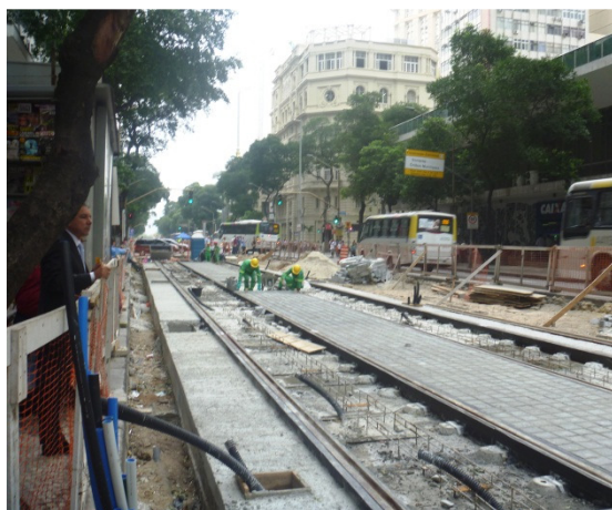
Foto 30 – Avenida Rio Branco. Serviços de assentamento de trilhos.
