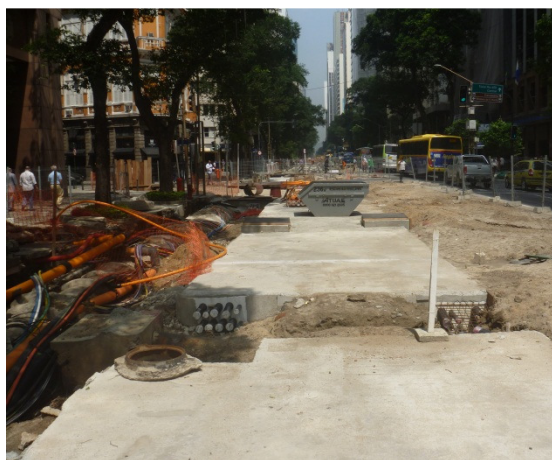
Foto 29 – Avenida Rio Branco – base de concreto da via permanente em execução.
