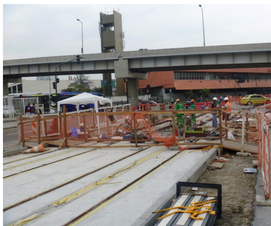
Foto 5 – Avenida Francisco Bicalho – trecho próximo à Rodoviária Novo Rio.
