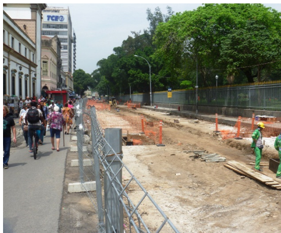
Foto 20 – Início das obras de escavação de trecho próximo à Praça da República.
