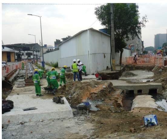
Foto 7 – Via Binário do Porto – bifurcação com a rua Equador.
