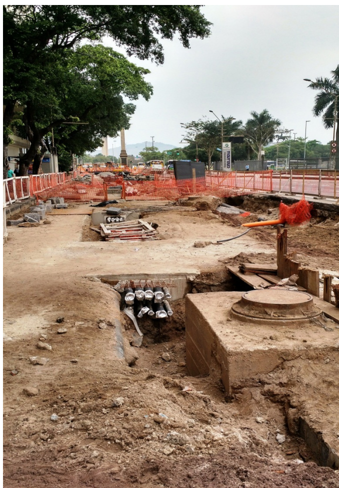
Foto 4 – Trecho da Avenida Rio Branco – trecho bastante atrasado.
