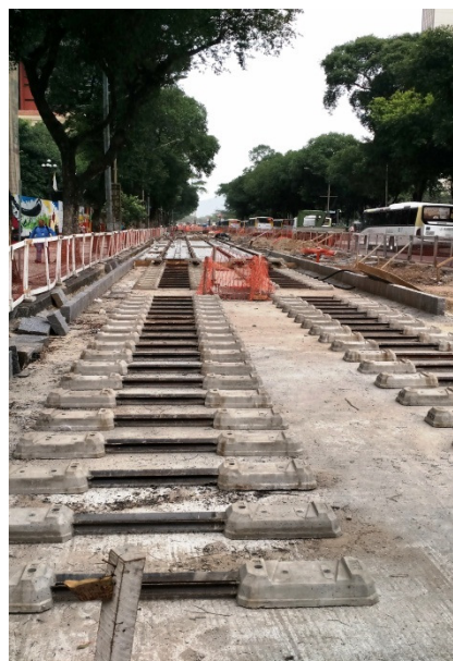
Foto 32 – Av. Rio Branco – assentamento de trilhos e dormentes.
