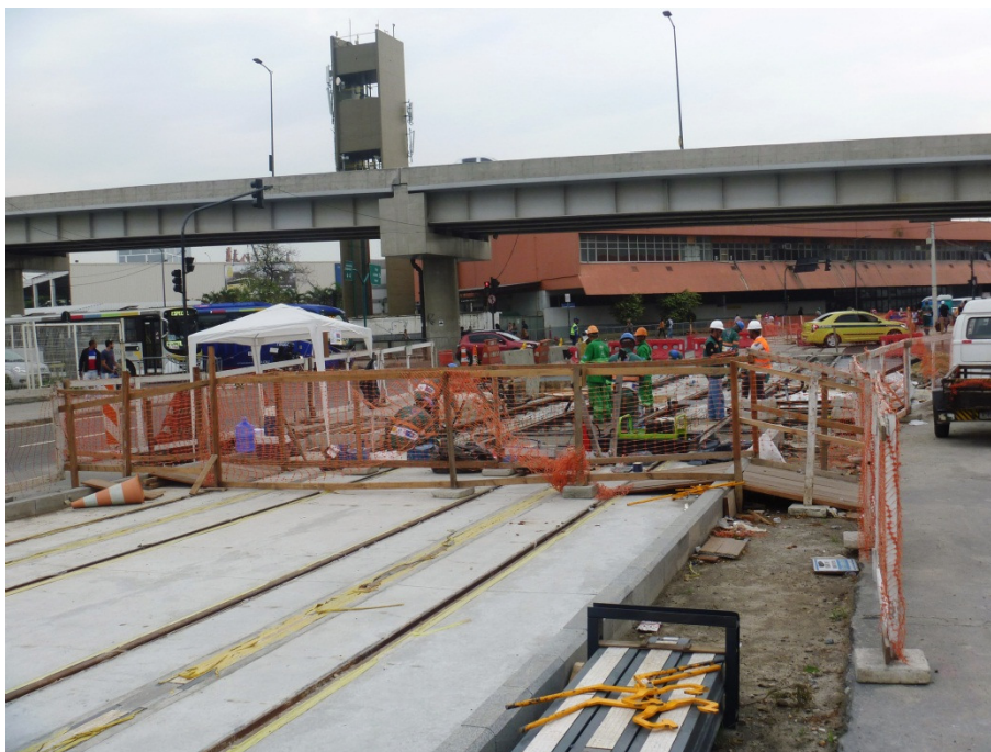
Foto 1 – trecho próximo à Rodoviária Novo Rio – trecho mais adiantado de execução da obra com os trilhos assentados e a via concretada.
