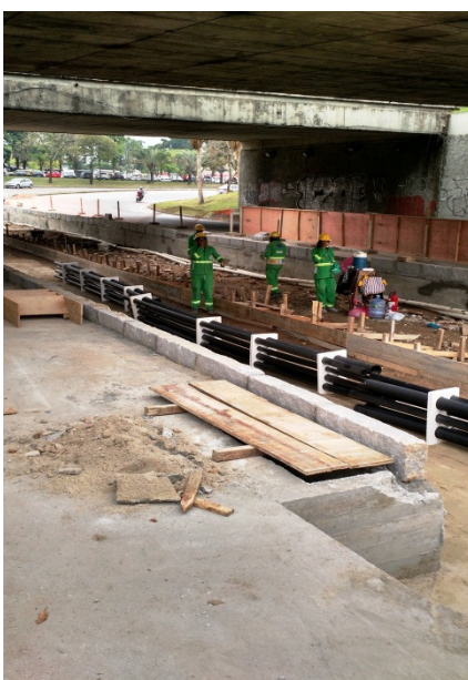
Foto 33 – Avenida Rio Branco – trecho final – serviços de escavação e concretagem da base.
