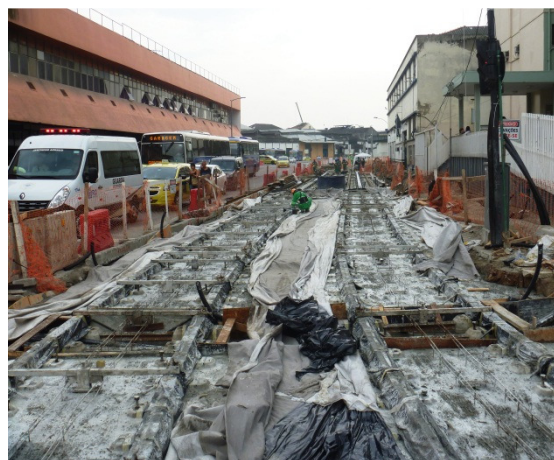
Foto 6 – Via Binário do Porto – execução de piso de concreto da Via Permanente.
