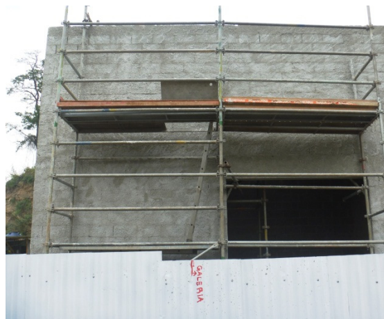
Foto 14 – Subestação de energia em execução – próximo à Praça de Santo Cristo.
