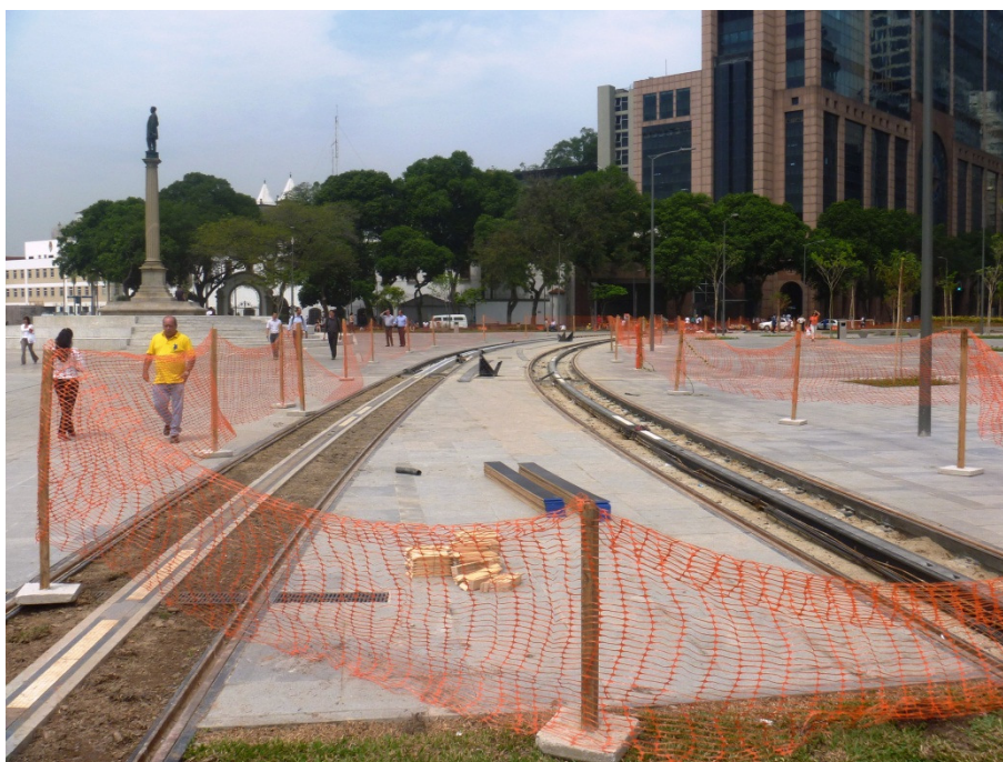
Foto 2 – Trecho próximo à Praça Mauá – trecho com a infraestrutura da via bastante adiantada.
