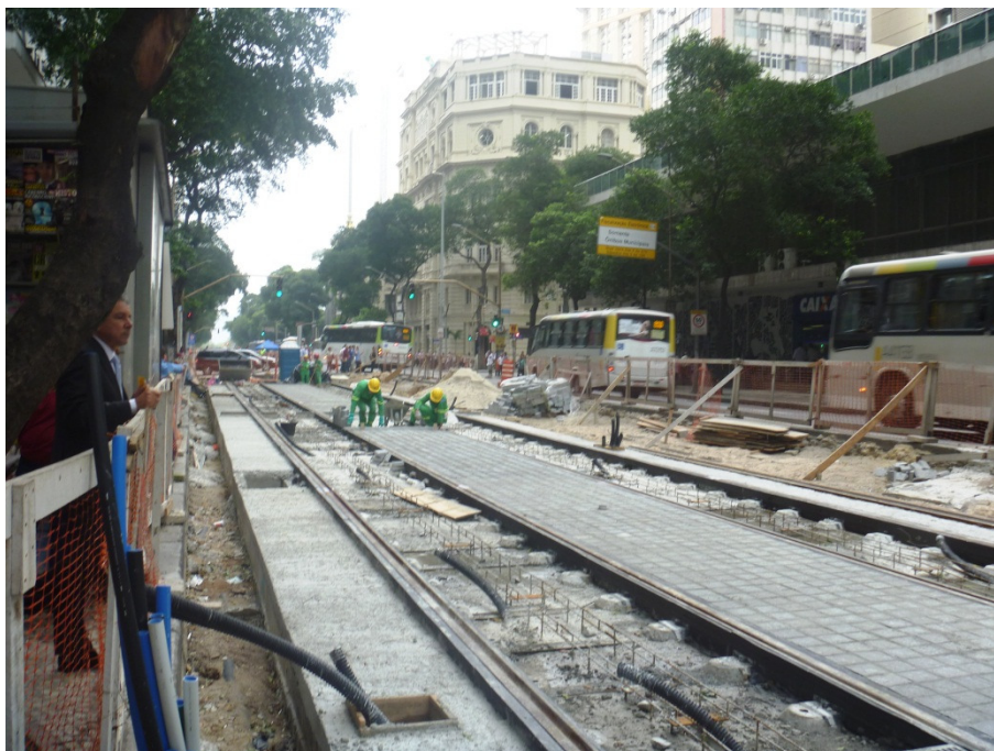
Foto 3 – Trecho da Avenida Rio Branco – trecho ainda em execução.
