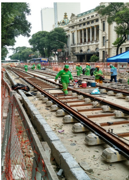
Foto 31 – Avenida Rio Branco – assentamento de trilhos e dormentes.
