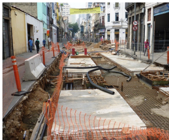
Foto 22 – Rua da Constituição – detalhe da instalação dos dutos de alimentação elétrica.
