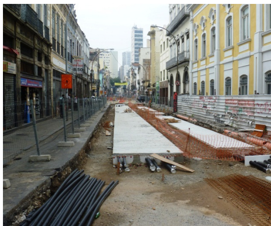
Foto 21 – Rua da Constituição – Obras de implantação da via Permanente
