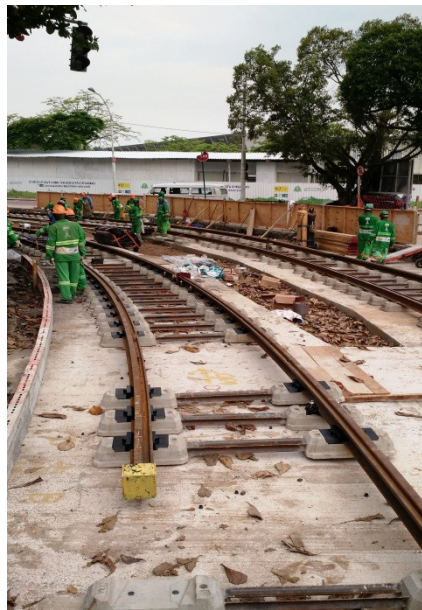
Foto 34 – Trecho de acesso ao Aeroporto – assentamento de dormentes e trilhos.
