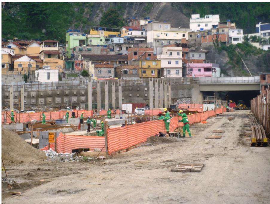
Foto 5 – Obras de Implantação do CIOM – Centro Integrado de Operação e Manutenção - Execução dos pilares em concreto armado.
