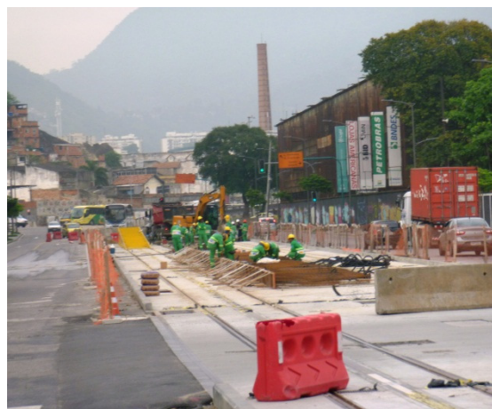
Foto 4 – Avenida Francisco Bicalho – Vista geral da execução dos serviços.
