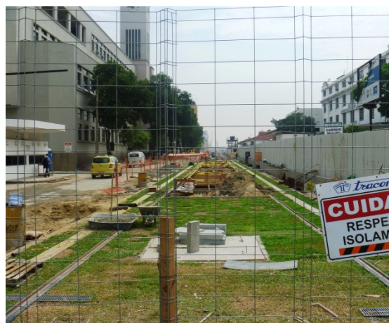
Foto 26 – Av. Rodrigues Alves – Praça Mauá – via permanente executada.
