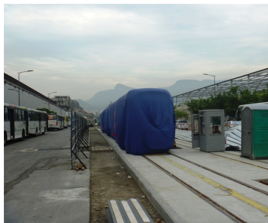
Foto 2 – Avenida Francisco Bicalho – detalhe da via permanente executada.
