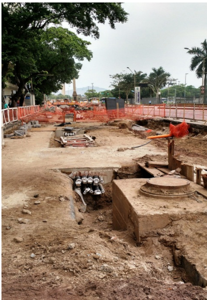
Foto 33 – Avenida Rio Branco – trecho final – serviços de escavação e concretagem da base.
