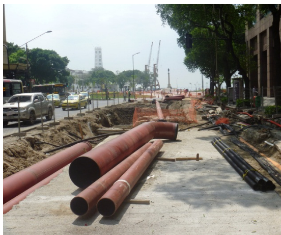
Foto 28 – Início da Avenida Rio Branco – obras de recuperação de adutora existente.
