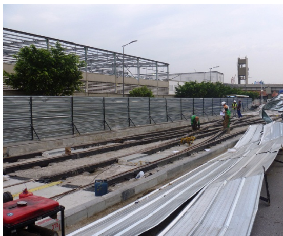
Foto 3 – Avenida Francisco Bicalho – instalação dos trilhos da via permanente.
