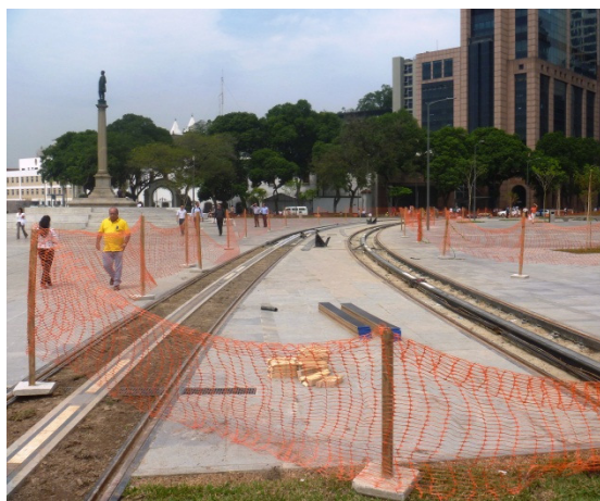
Foto 27 – Praça Mauá – Via Permanente executada.
