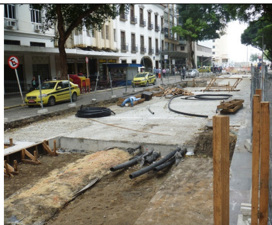
Foto 22 – Rua da Constituição – detalhe da instalação dos dutos de alimentação elétrica.
