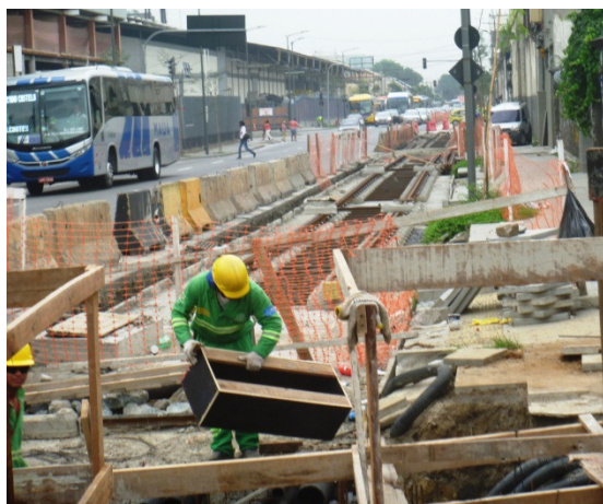
Foto 13 – Via Binário do Porto – caixa para instalações elétricas em execução.
