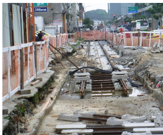
Foto 8 – Rua Equador – Assentamento de dormentes e trilhos.
