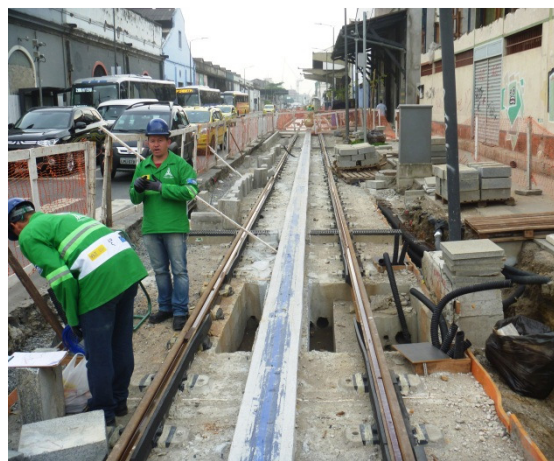
Foto 10 – Via Binário do Porto – detalhe dos serviços de lançamento dos dutos de PVC.
