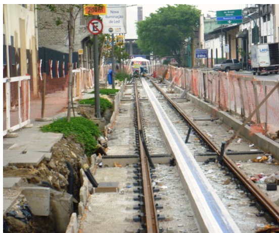
Foto 9 – Via Binário do Porto – Instalação do terceiro trilho de alimentação do VLT.
