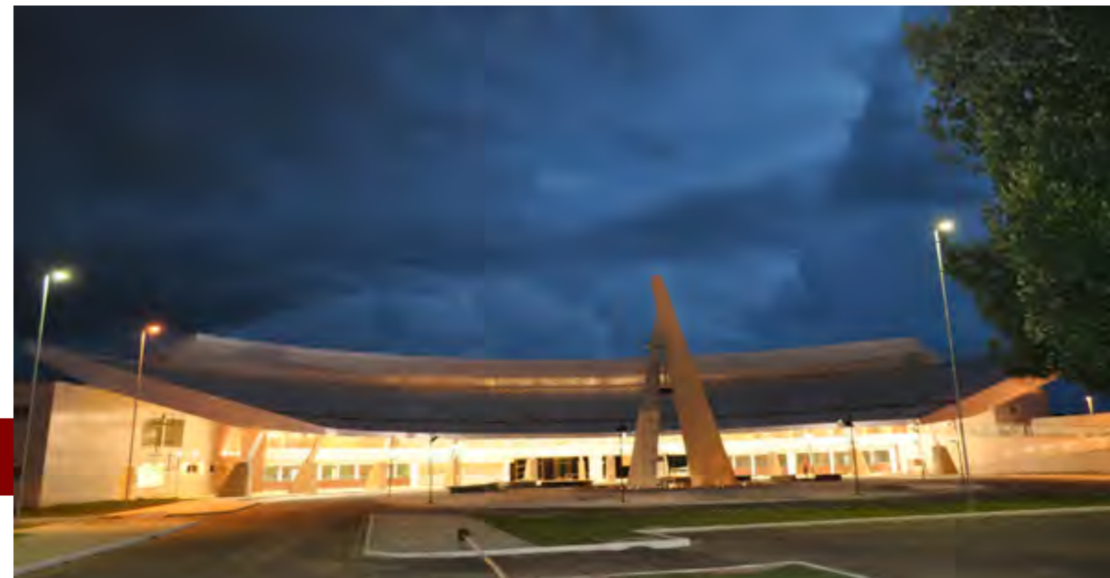
➔ Construção da nova Rodoviária Internacional de Rio Branco, preparando a cidade para o futuro.
