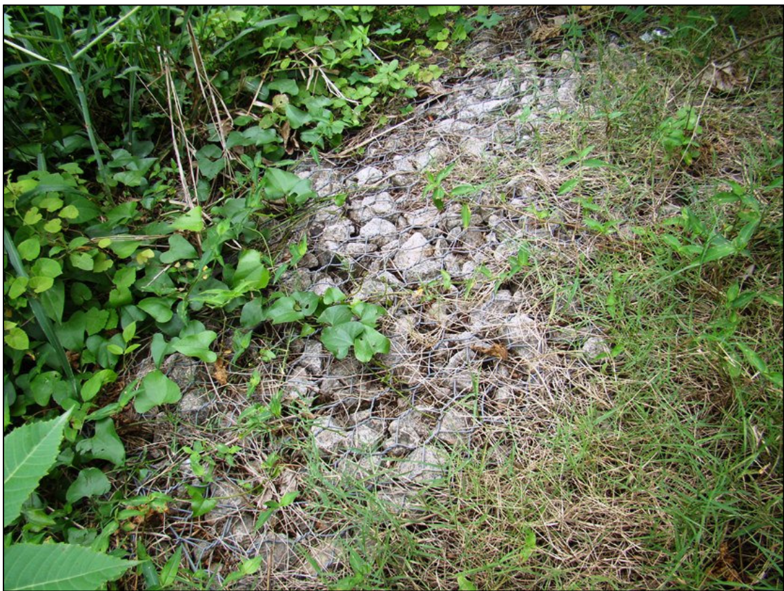
Foto 07– Rio Pequeno canal revestido com gabiões/colchão Reno – Coordenadas 22° 54'54,8"S 43°25'18,8"O–Rio de Janeiro (RJ), 26/10/2015.
