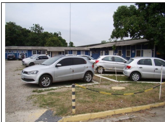
Foto 20 – Canteiro de obras do Consórcio Rios de Jacarepaguá em atividade–Coordenadas 22°57'05,6"S e 43°22'15,5"O– Rio de Janeiro (RJ), 26/10/2015.
