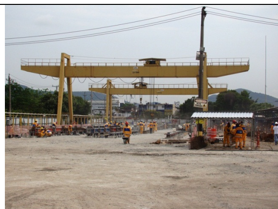
Foto 21– Central de pré-moldados do Consórcio Rios de Jacarepaguá em operação –Coordenadas 22°57'05,6"S e 43°22'15,5"O– Rio de Janeiro (RJ), 26/10/2015.
