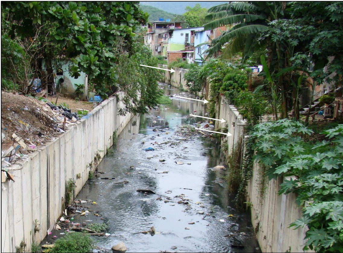
Foto 02– Registro de ligações clandestinas de esgoto no canal do rio Grande, em trecho de obras já executadas. Foto obtida sobre a ponte da estrada do Curumaú, Coordenadas: 22°54'55,0"S e 43°24'05,2"O. Rio de Janeiro (RJ), 26/10/2015.
