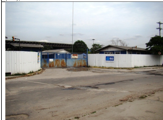
Foto 22–Canteiro de obras mobilizado no Contrato nº 093/2011 em uso para a fabricação de estruturas pré-moldadas de concreto para obra diversa –Rio de Janeiro (RJ), 26/10/2015.
