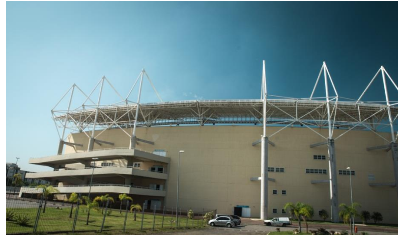
Foto 2 - Heitor Vilela / COB: Estrutura Externa Centro Aquático
