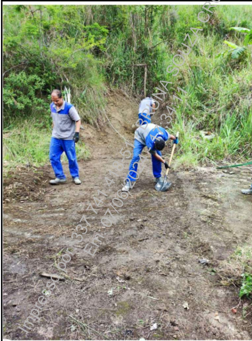
Anexo 8: mostrando o final dos trabalhos na via de acesso localizada dentro do MOTEL TABA.
