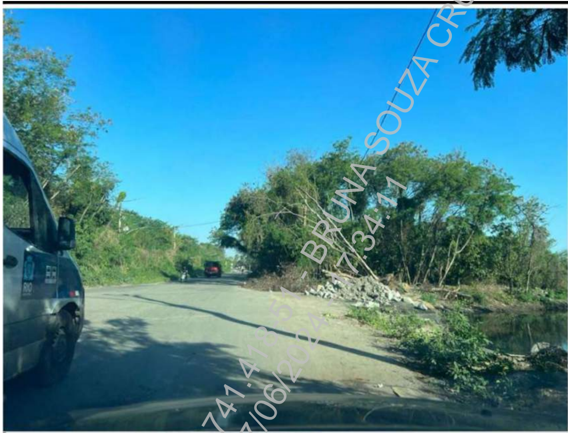
Anexo 2.4: Mostrando de um ângulo mais afastado a proximidade entre as margens da Av. Engenheiro Souza Filho e Córrego após intervenção da Prefeitura do Rio de Janeiro.
